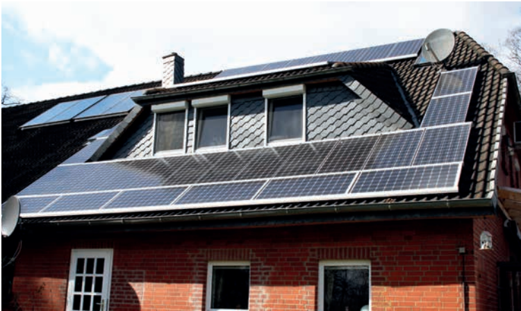
Eigenheim in OHZ mit Solar-Pannels
