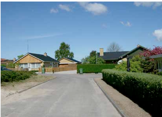
Umbauten an Eigenheimen im Projektgebiet Middelfart
